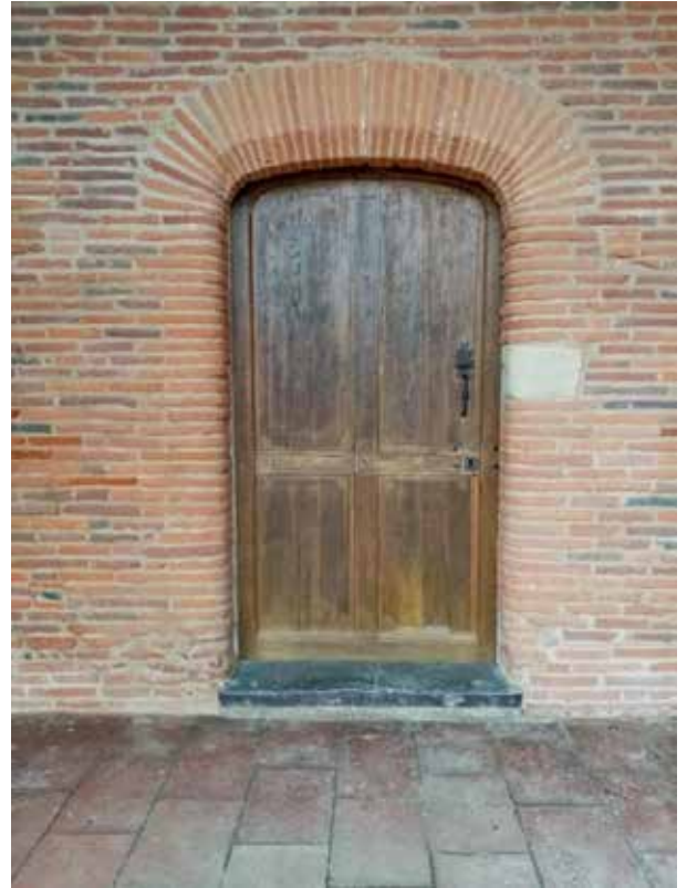
Merci à Michel et à Guy pour avoir rénové la porte d'entrée de notre belle église
